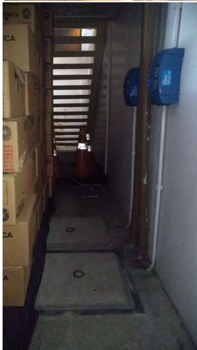
Figura 12: Materiais alocados no estacionamento obstruindo extintores e caixas de energia
