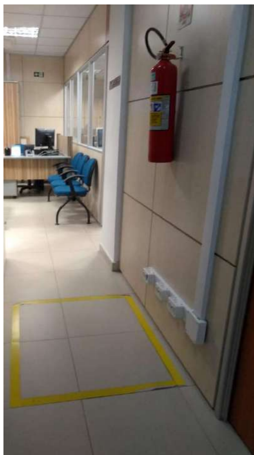
Figura 48: Extintores não sinalizados corretamente (sede e anexo)
