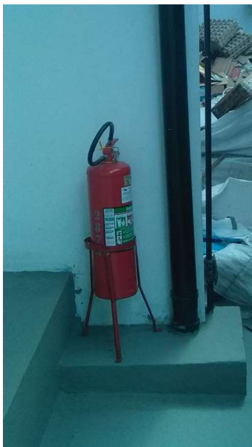
Figura 48: Extintores não sinalizados corretamente (sede e anexo)
