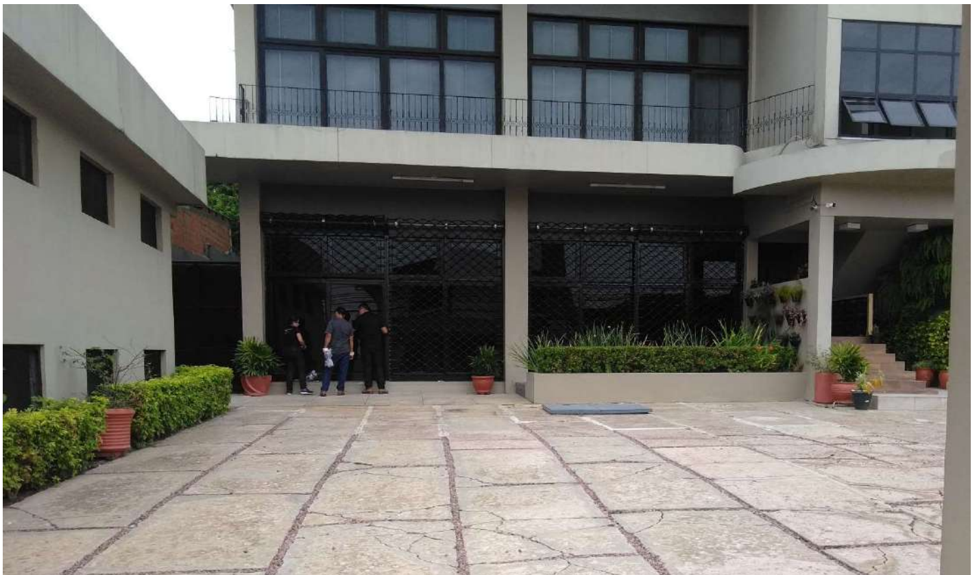
Figura 47: Área externa frontal do depósito.
